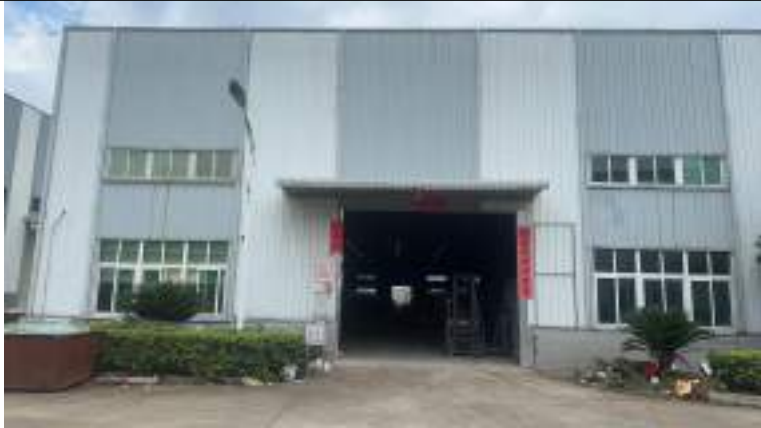
项目厂区大门
