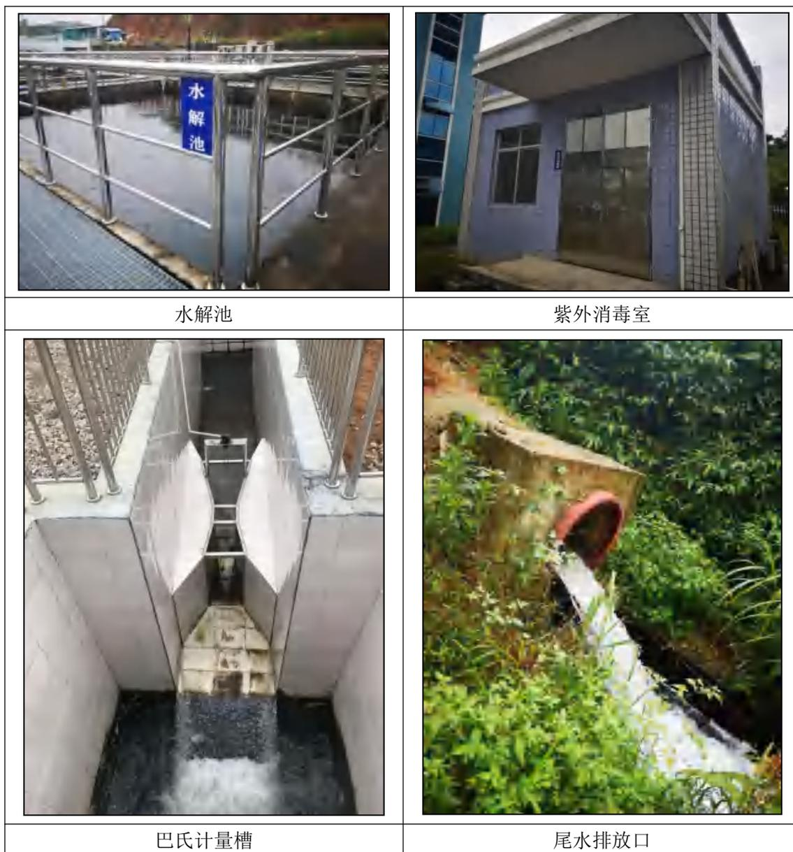
图 4.1-2 污水处理厂构筑物图
