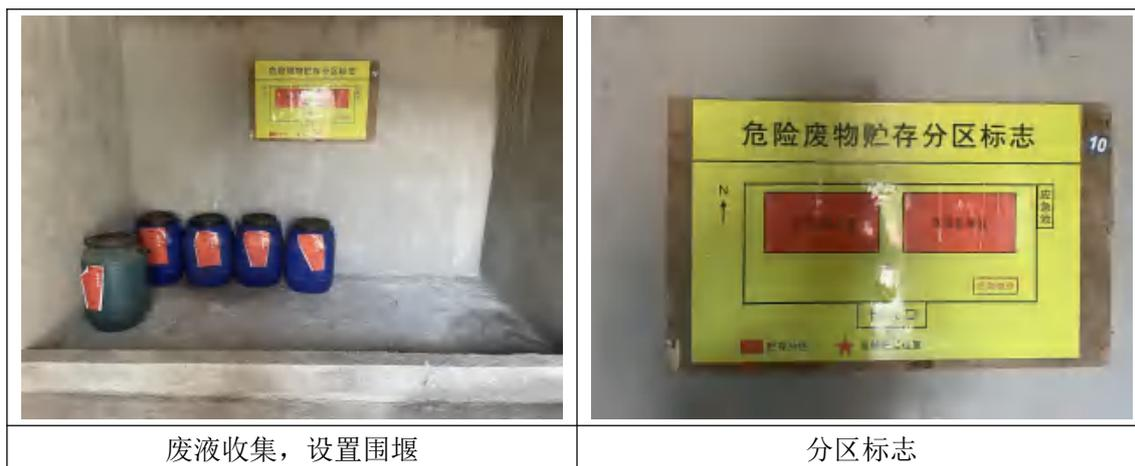
图 4.1-6 固体废物处置设施
