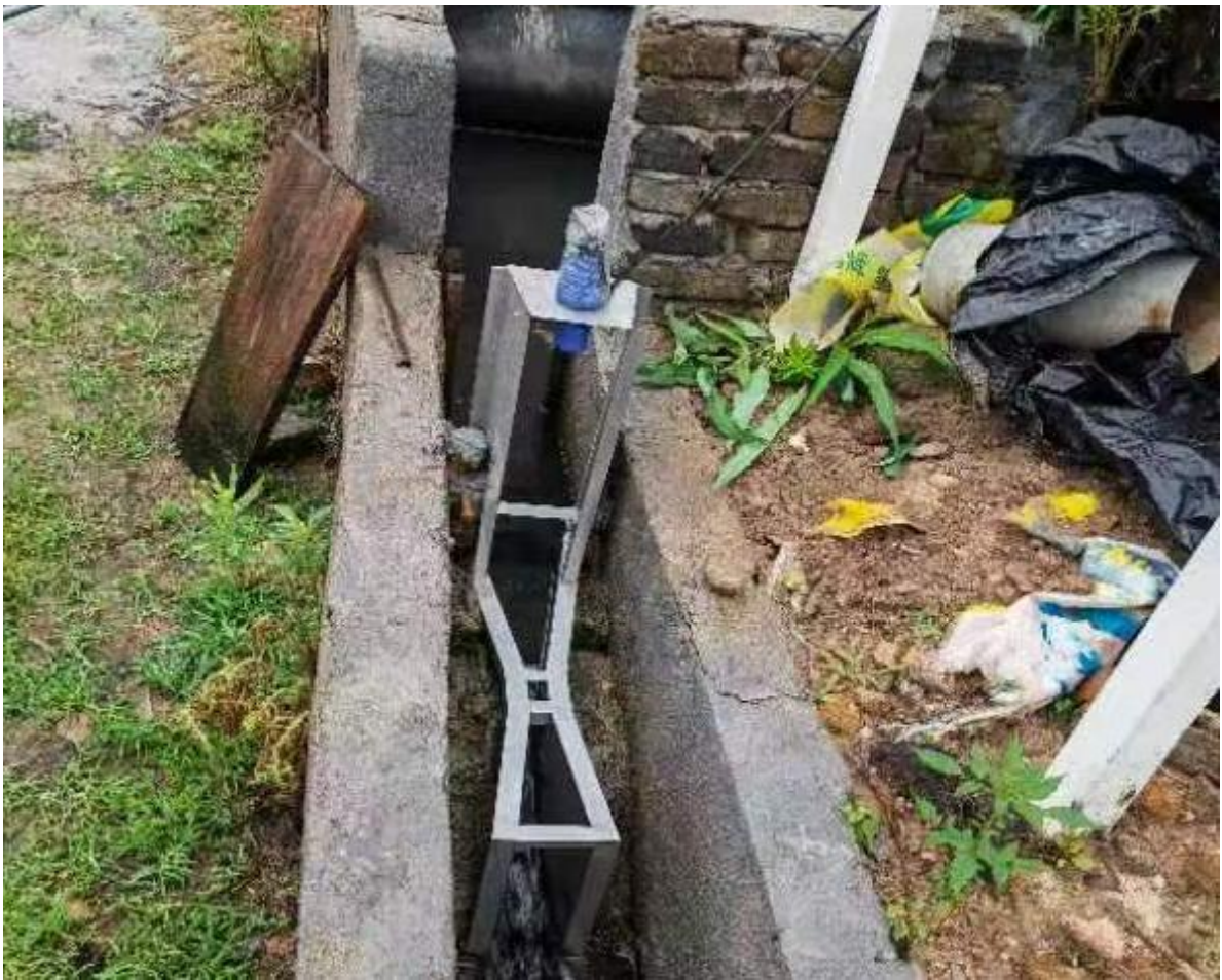
废水处理处理设施
