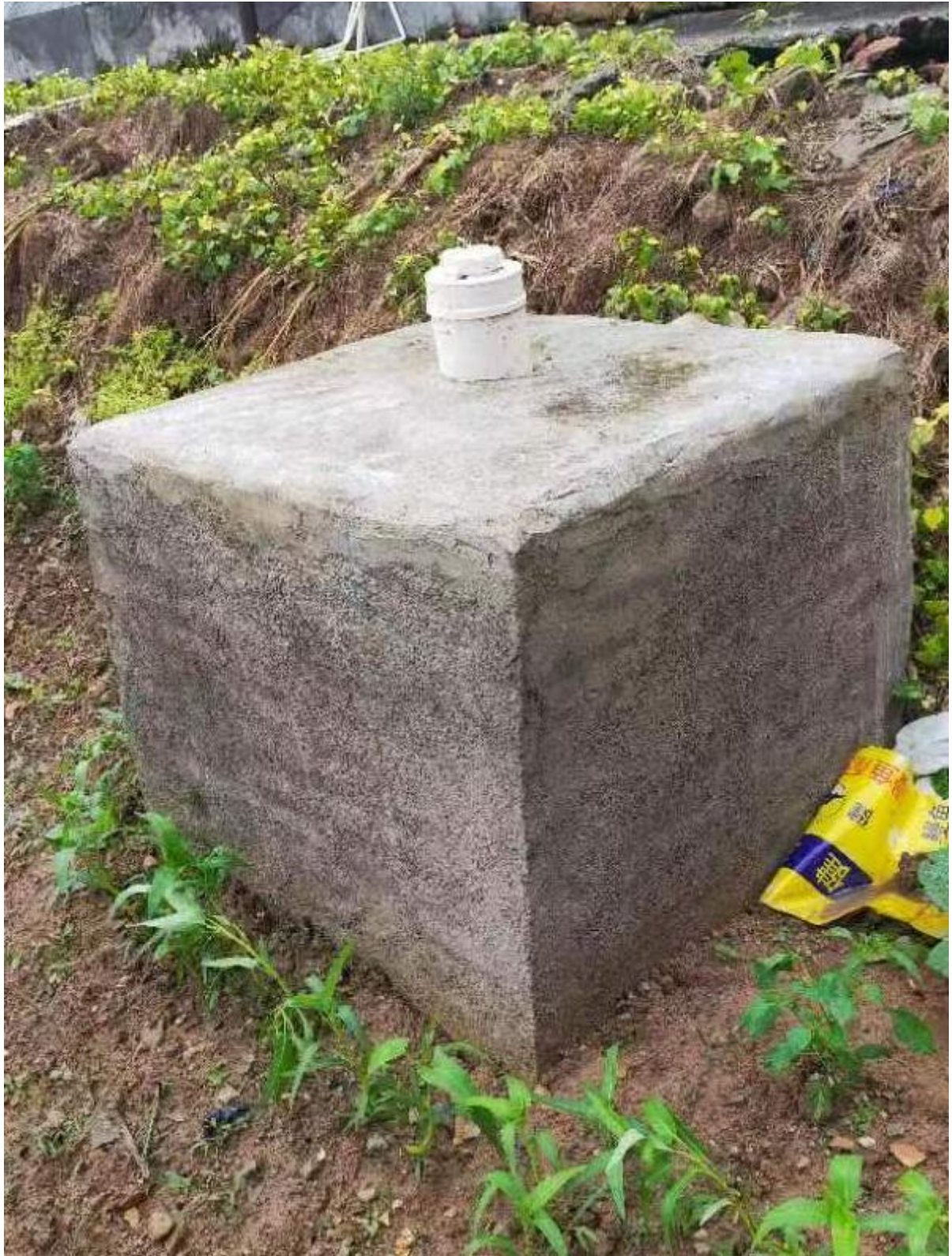
一般固废暂处（安全填埋井）
