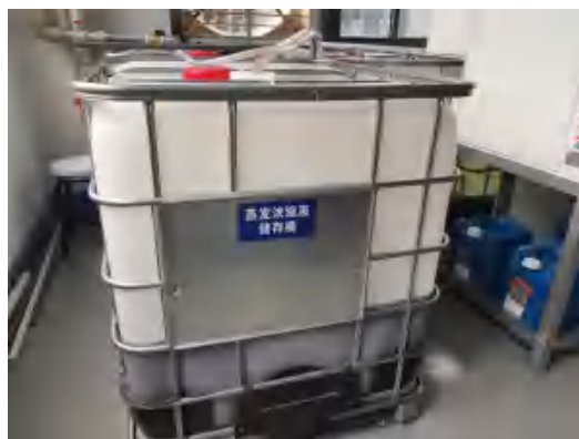
蒸发浓缩液储存桶
