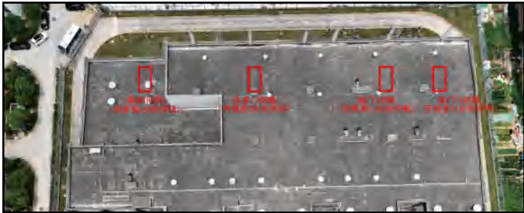
图 2-4 鹤林 220kV 变电站间隔扩建侧现状情况
