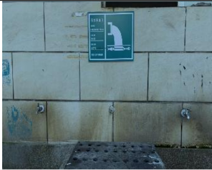
生活污水排放口
