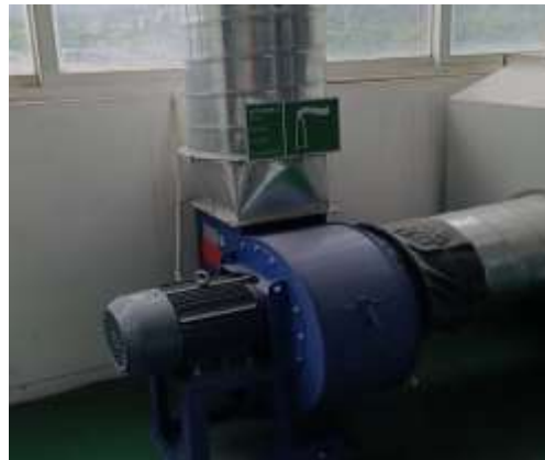
废气排气筒规范化排放口
