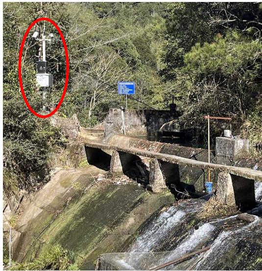
下泄流量监控系统
