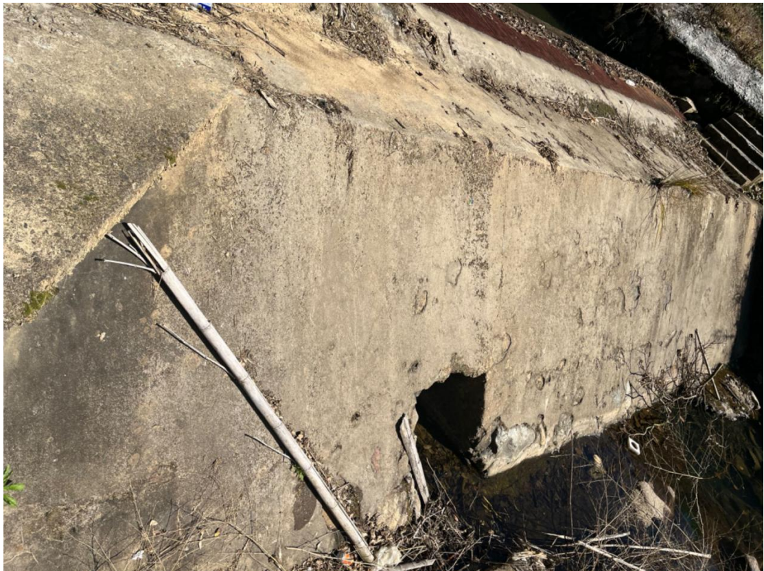
图 5.2-1 引水渠留设出水口
