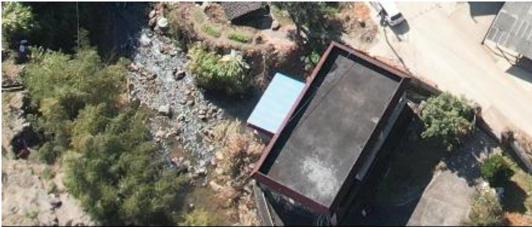
图 5.1-1 张家山二级电站厂房周边植被
