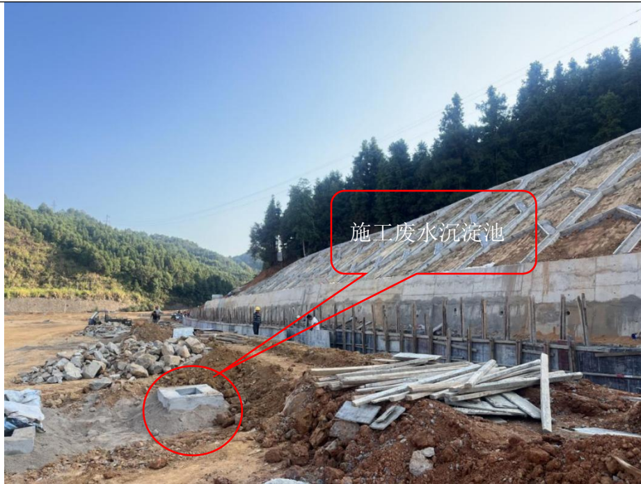
图 4-4 施工期水环境保护措施情况
