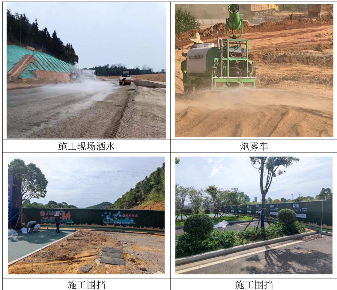
图 4-5 施工期大气环境保护措施情况
