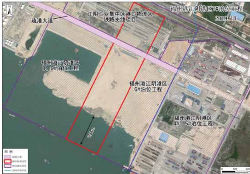
图 2.2-2 福州港江阴港区7#泊位工程建设情况（2019.10）
