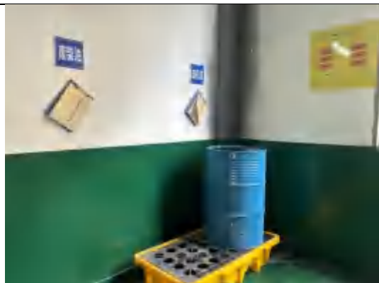
废液油仓库内部
