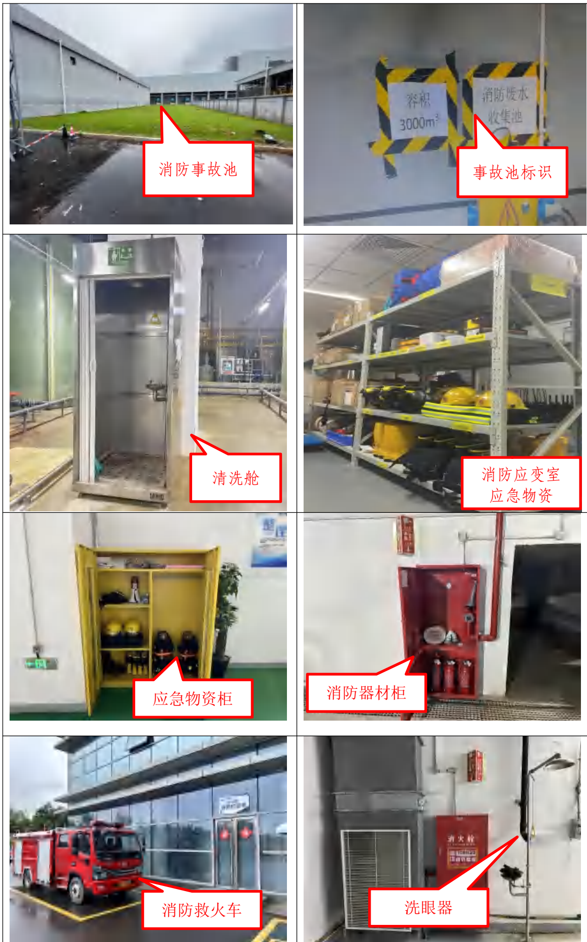
图 3.6.2 防控措施及应急措施现状照片
