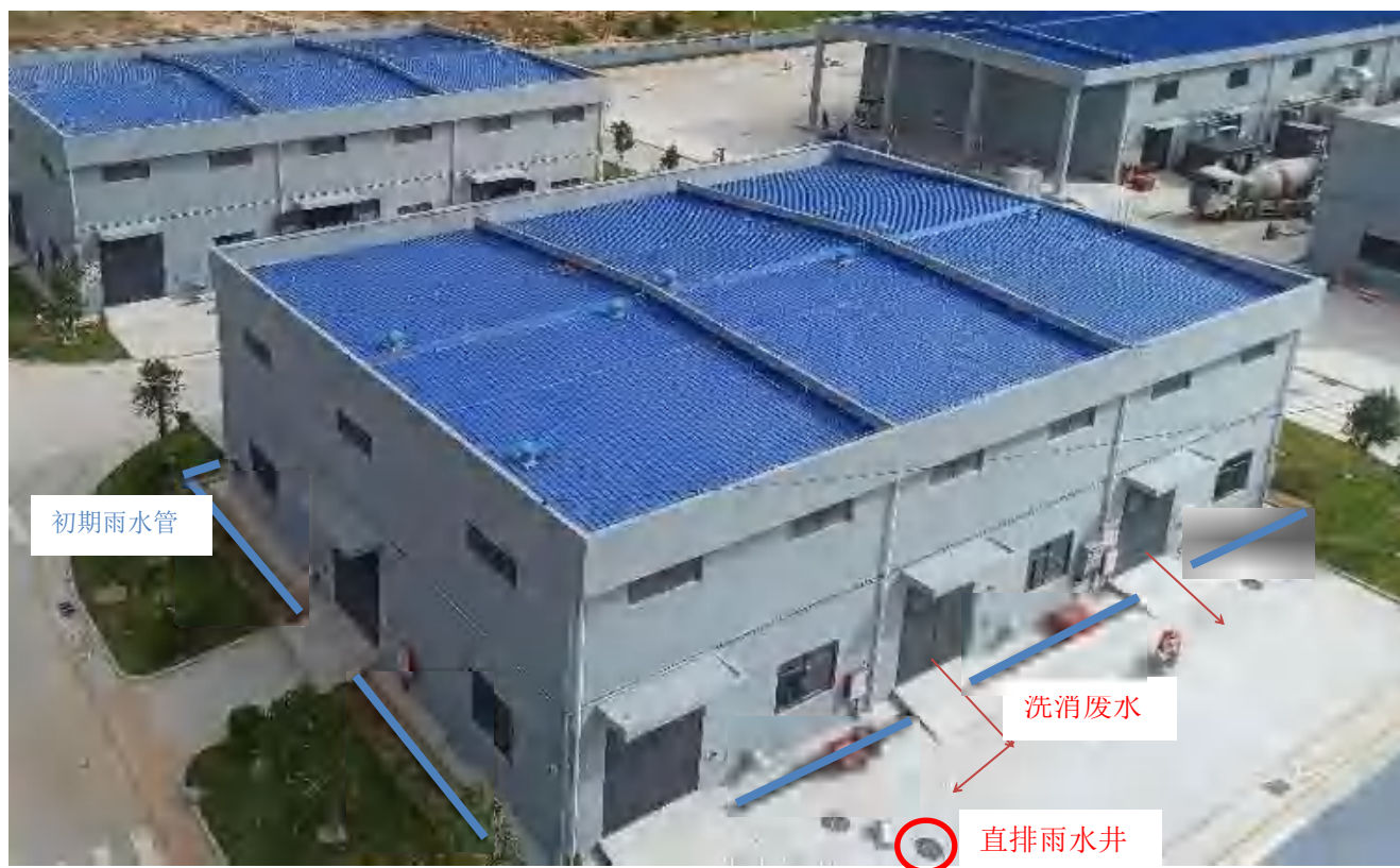
图 4.6-2 厂房周边雨水管道
