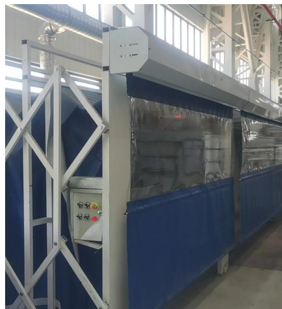
铺贴喷胶工作区软帘密闭
