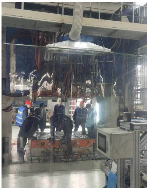
固化工序软帘密闭
