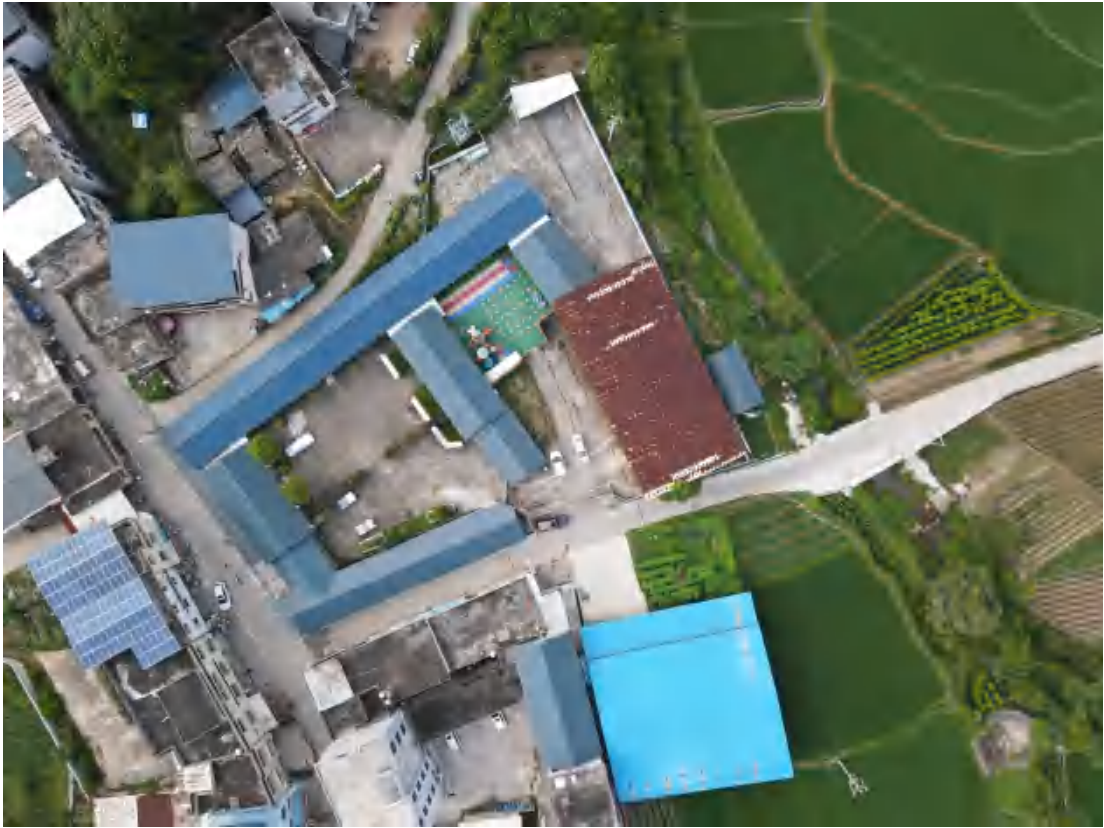
图 5.1-1：项目地块现场踏勘影像
