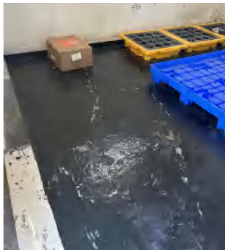
危险废物暂存间（内部）
