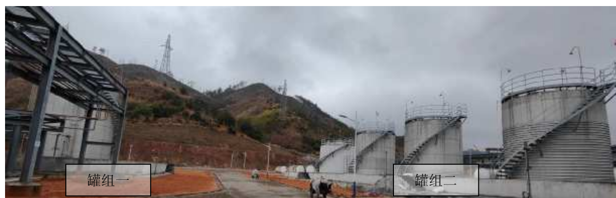
地块二罐组一和罐组二
