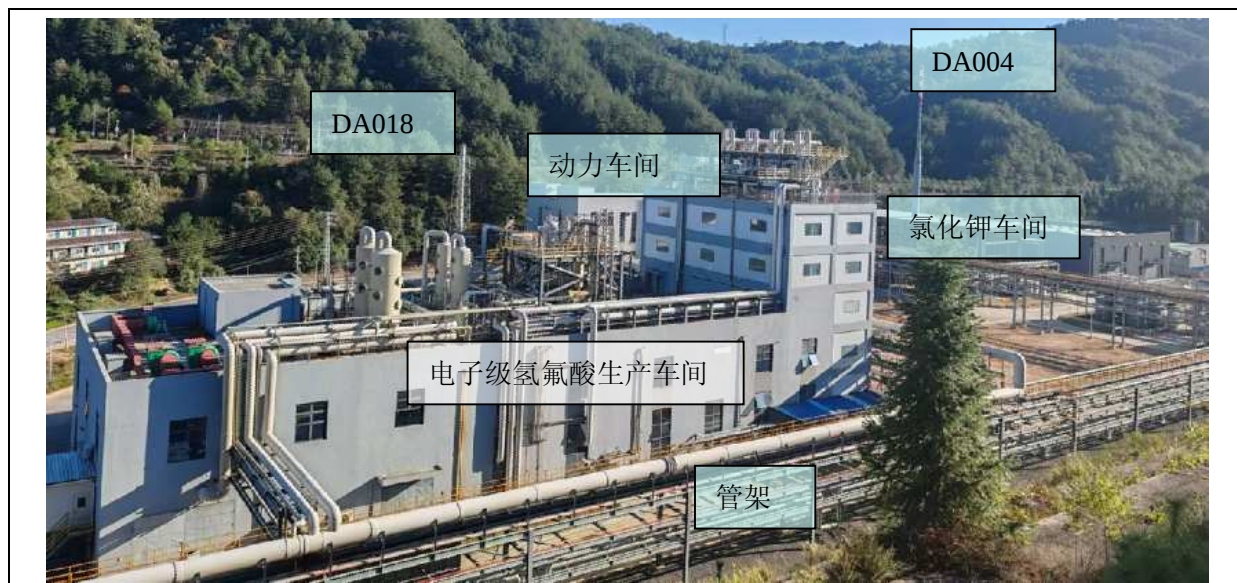
地块三电子级氢氟酸车间、氯化钾车间及排气筒、动力车间
