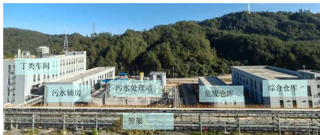
地块三车间、危废库、仓库及污水处理站
