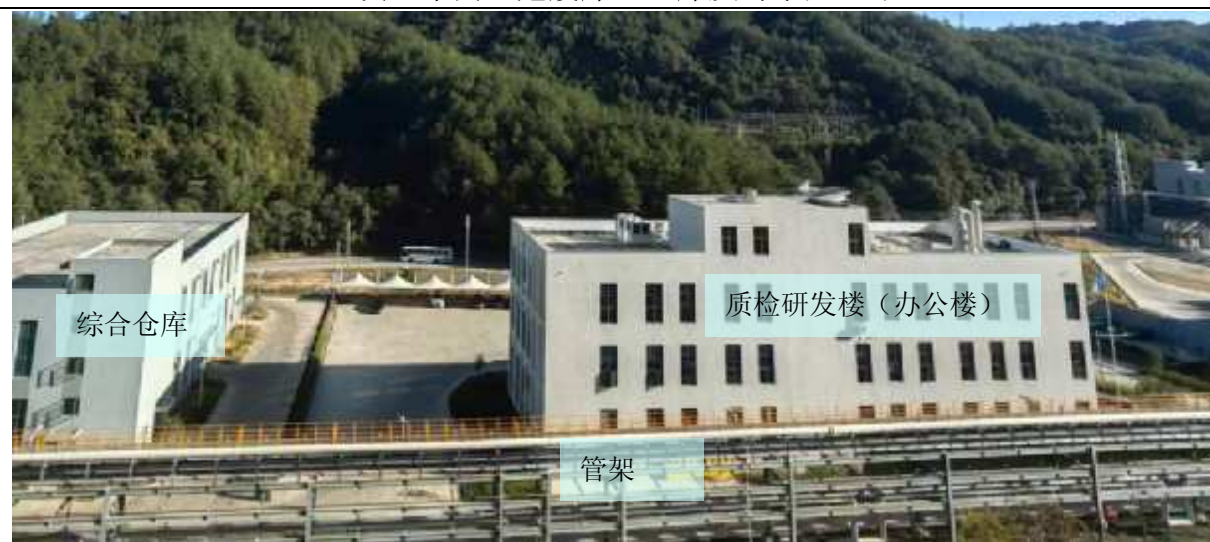
地块三危废仓库、综合仓库、质检研发楼及管架
