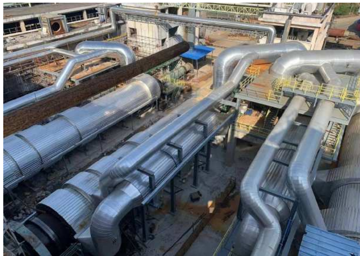
地块一氟化氢生产区
