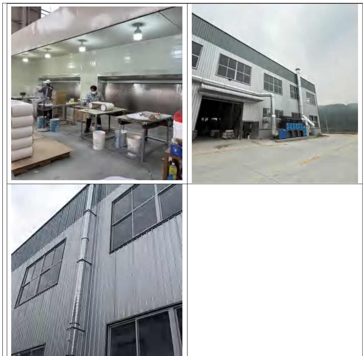
图 3-2 废气治理措施现场照片
