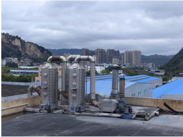
1)压铸废气处理措施（水喷淋塔过滤器+活性炭吸附装置+15m 排气筒（DA001））
