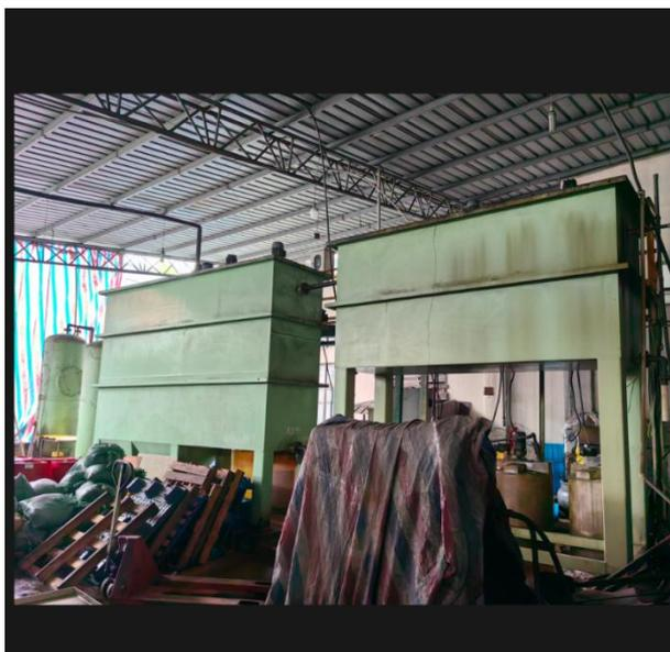
生产废水处理设施(芬顿氧化+混凝沉淀处理工艺)
