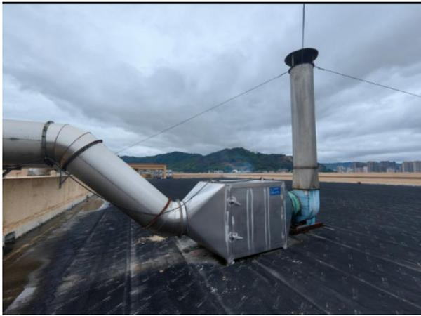
注塑废气处理措施（活性炭吸附装置 15m 排气筒（DA006））
