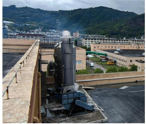
压铸废气处理措施（水喷淋塔过滤器+活性炭吸附装置+15m 排气筒（DA003））
