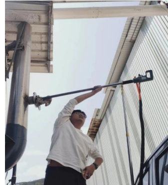
Q5破碎粉尘治理设施进口
