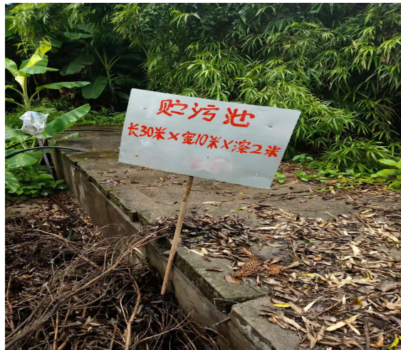
厂区 600m 3 贮污池 规格：厂 30m×宽 10m×高 2m
