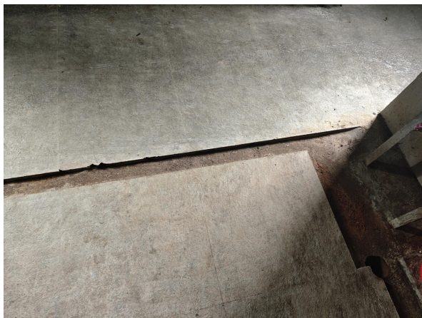
车间污水收集管道
