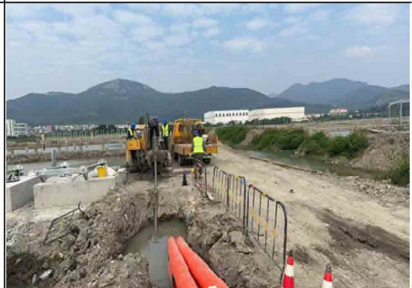
施工的简易沉淀池
