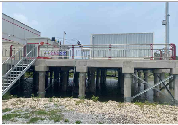
升压站下恢复鱼塘养殖
