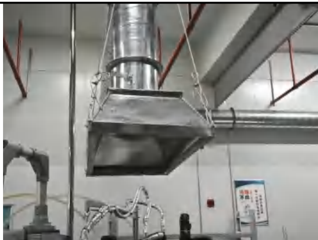
家用膜车间混胶工序集气罩
