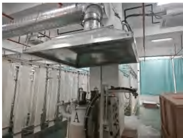
2F 混胶工序集气罩
