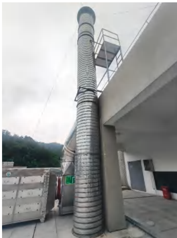
有机废气排气筒
