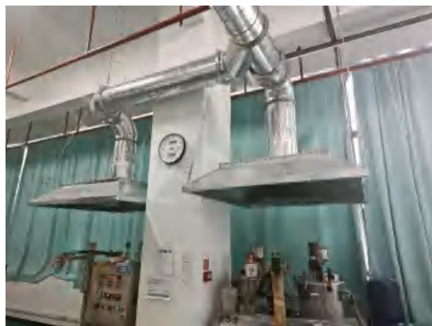
2F 混胶工序集气罩
