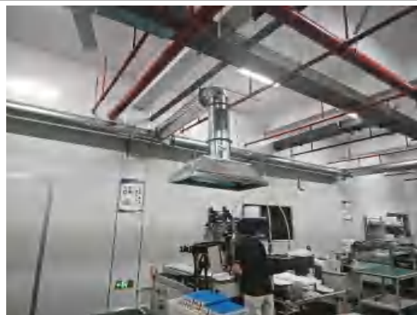
打胶封边收卷等工序集气罩
