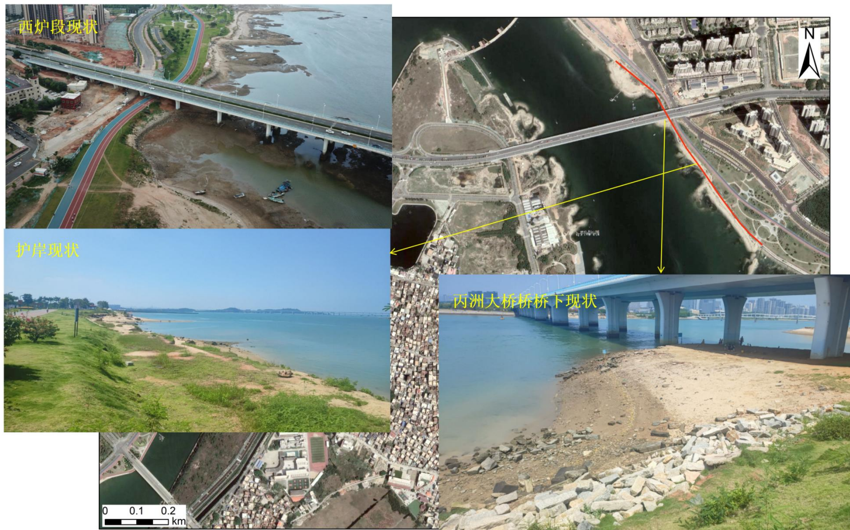
图 3.1-3 西炉段现状情况
