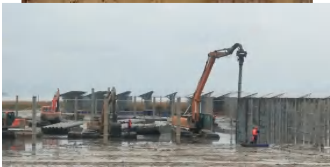
图 2.7-1 水陆两栖打桩机施工示意图
