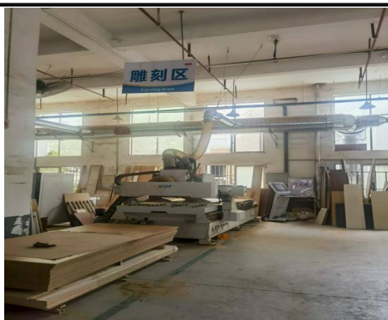
粉尘收集措施
