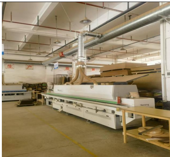
粉尘收集措施
