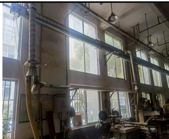
粉尘收集措施
