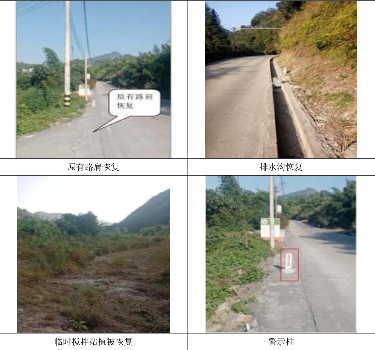
图 4.1-1 温泉管道施工场地恢复现状图
