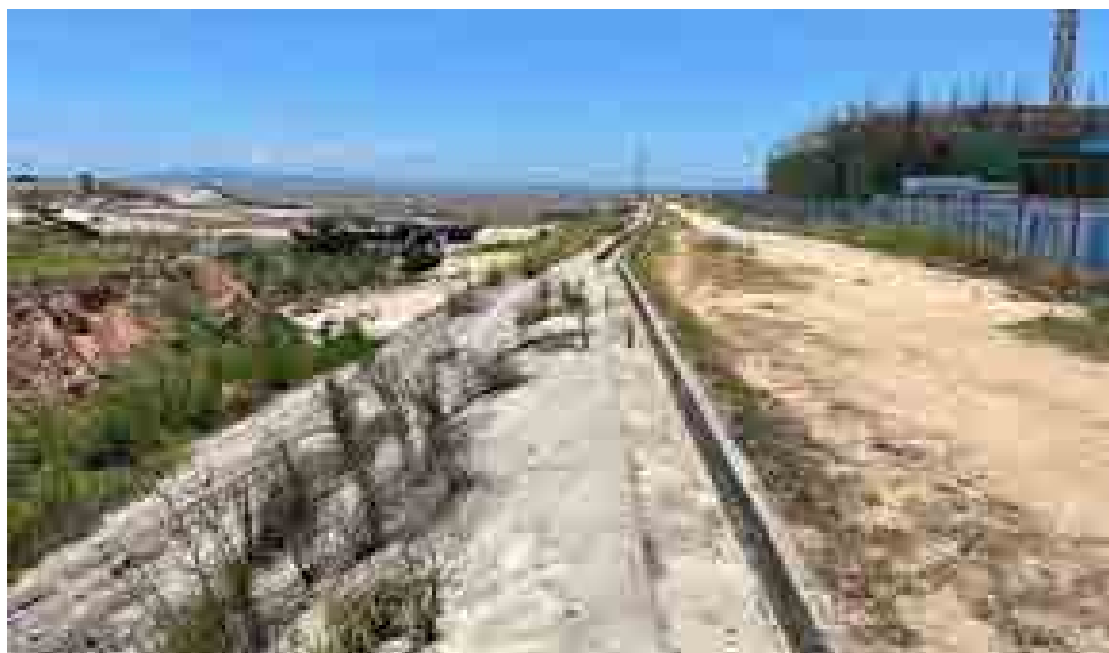
图 2.1-7 喷射砼护面
