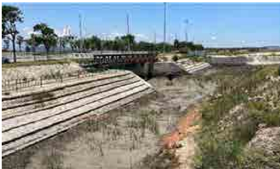
图 2.1-9 滨海东大道横跨海沟处护面照片
