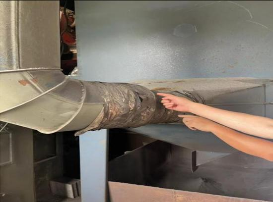
抛丸机废气管道破损
