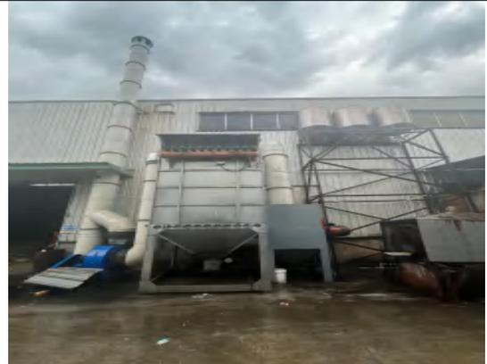
熔炼炉除尘器未配套粉尘收集
