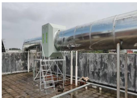
喷淋洗涤+余热回收+静电处理+活性炭吸附
