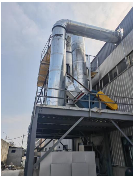
喷淋洗涤+余热回收+静电处理+活性炭吸附
