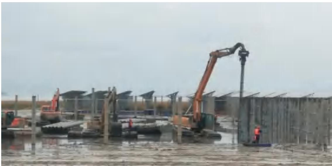
图 2.7-1 水陆两栖打桩机施工示意图
