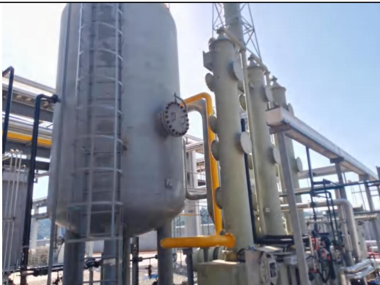
有机胺中间体工艺废气治理设施（一级水洗+二级酸洗）
