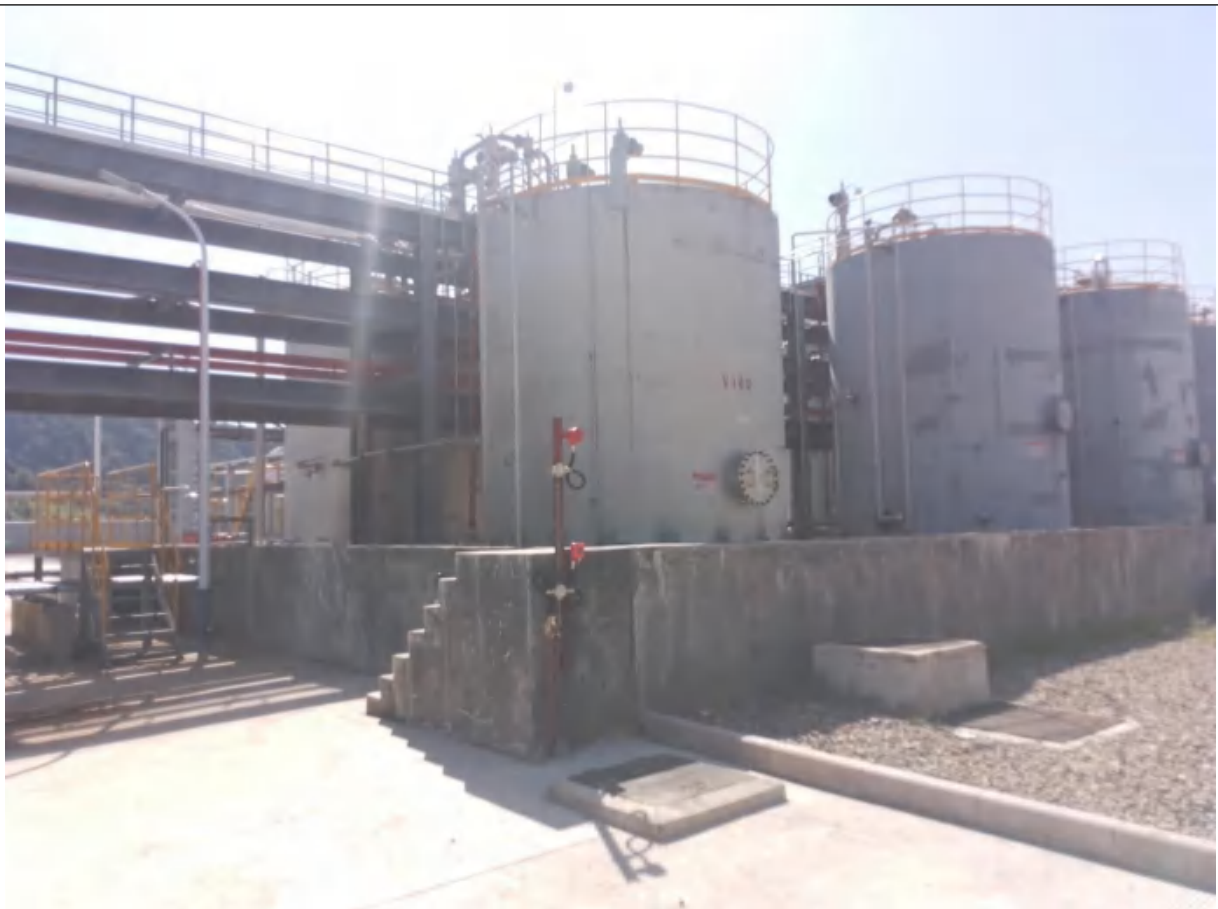
原料成品罐区围堰
