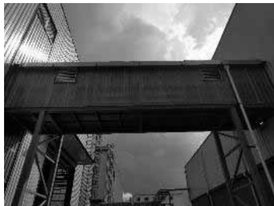
原料输送皮带机密闭长廊（连接转炉车间烘干炉）
