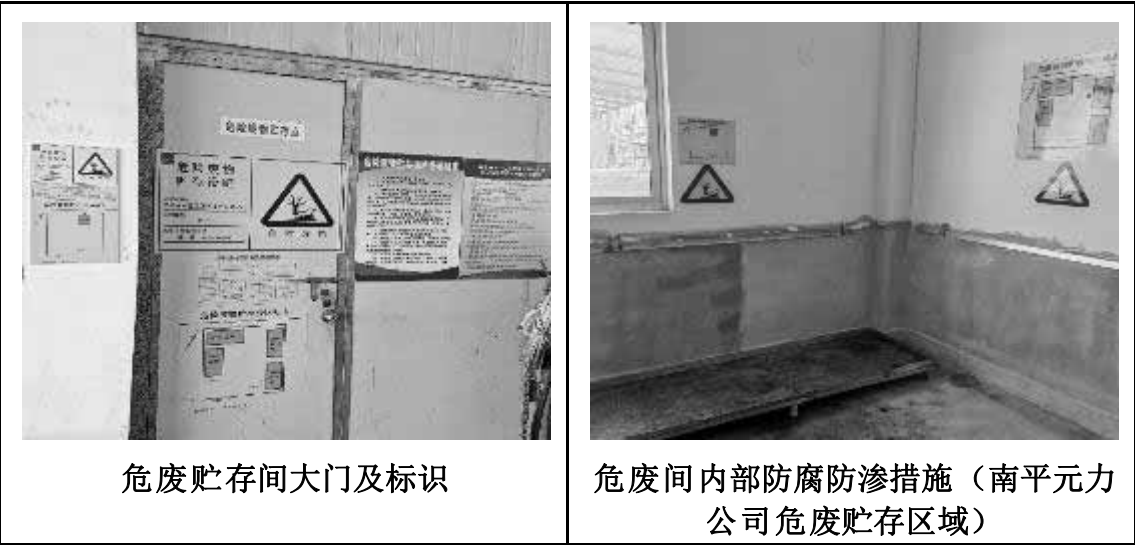
图 4.1-8 危废贮存间现场设施情况图
