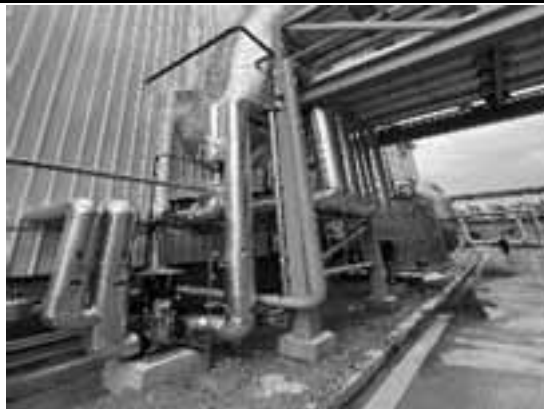
天然气管道（黄色）
