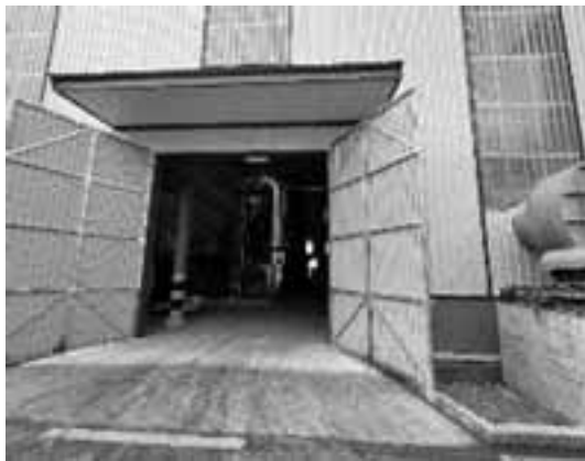
转炉车间墙体隔声
