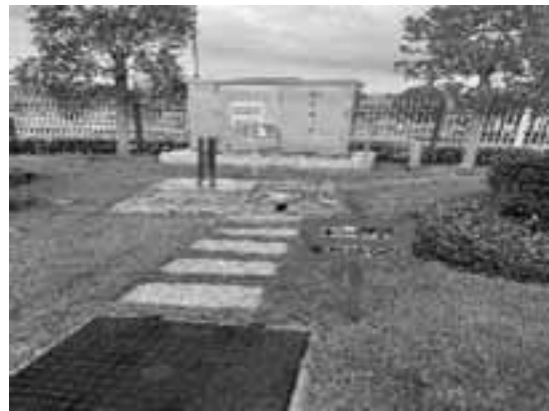
天然气主供应阀和雨水总排口
