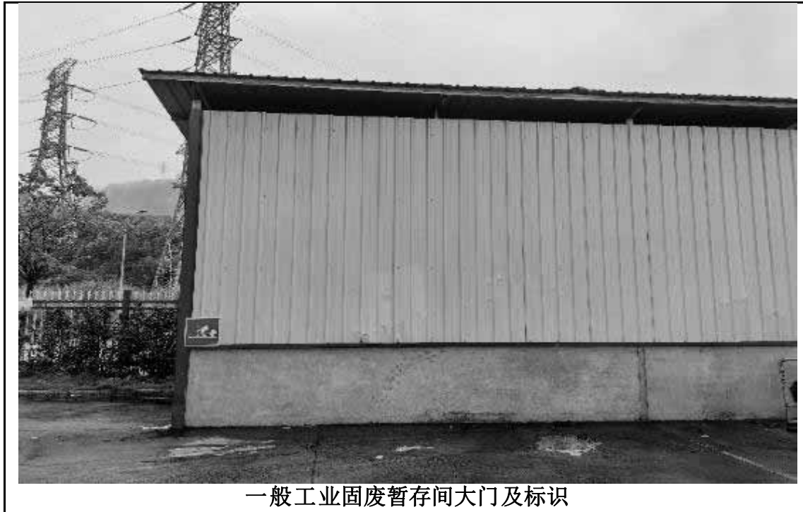
图 4.1-9 一般固废贮存场所现场设施情况图
