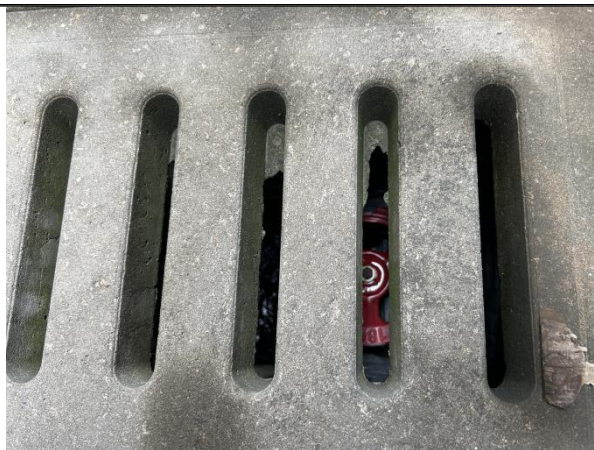
雨水切断阀
