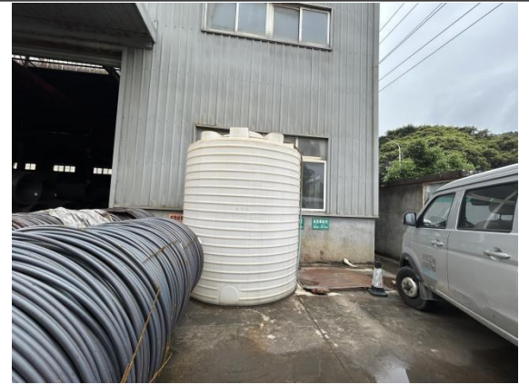
事故应急池及应急罐
