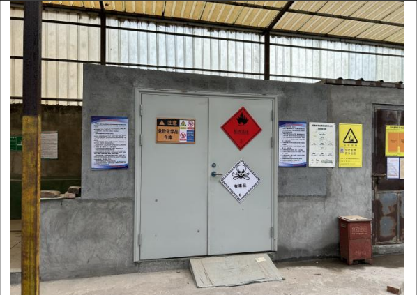
化学品仓库外部
