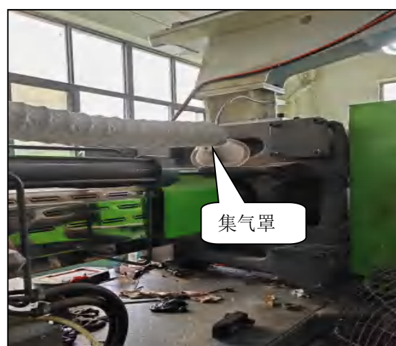
图 4-1-17 注塑工序集气罩
