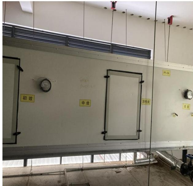
生物制品车间废气通过三级过滤装置处理后引至屋面排放 (DA008排气筒)
