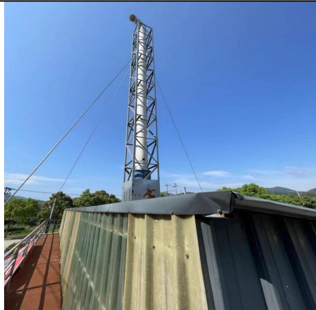
污水处理站废气通过风机收集活性炭吸附除臭 (DA006排气筒)
