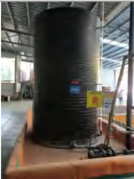
图 4.9 废酸储罐 (1 个)
