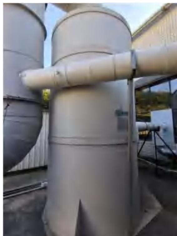
图 4.4 萃取废气碱液喷淋塔
