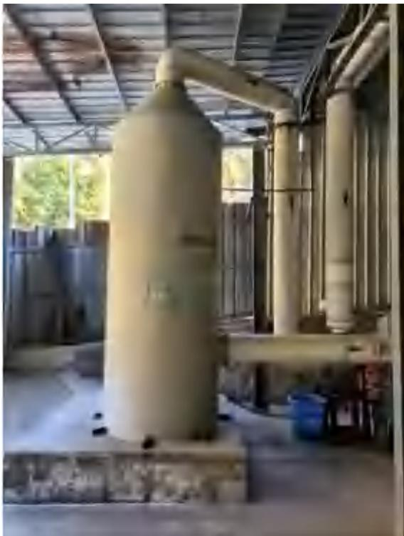
图 4.1 浸出废气碱液喷淋塔
