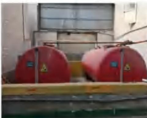
图 4.11 厂区中部硫酸储罐 (2 个)
