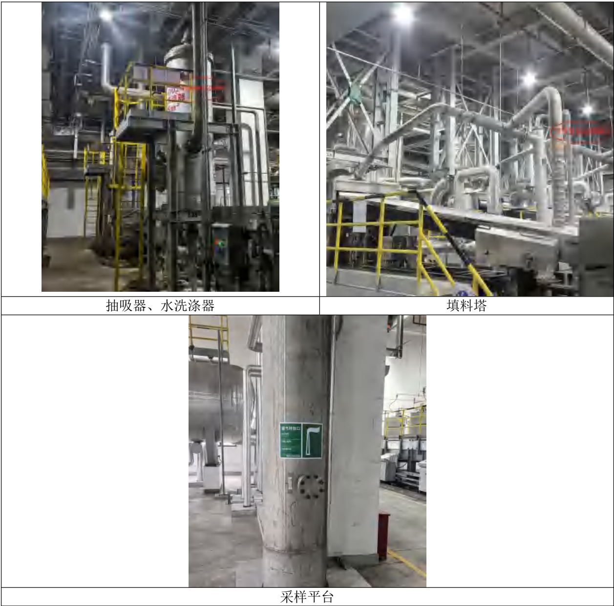
图 4.2-2 聚酰胺生产装置尾气处理设施图
