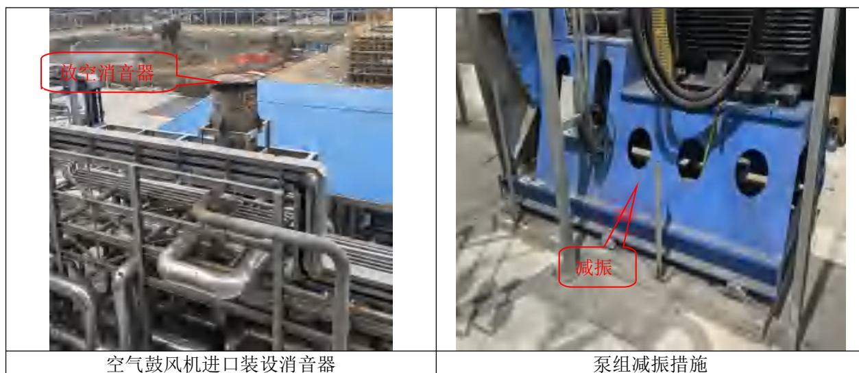
图 4.3-1 聚酰胺生产装置噪声控制措施图
