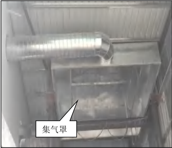
图 4-1-1 投料工序集气罩
