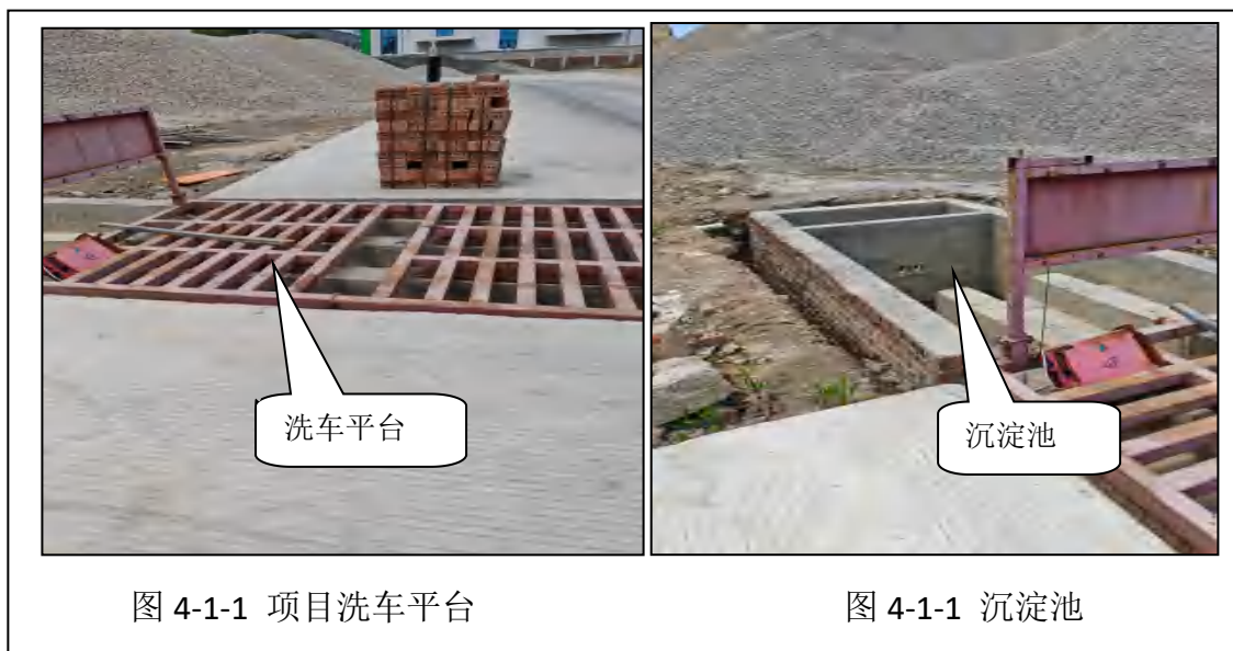
图 4.1-1 洗车平台及沉淀池照片
