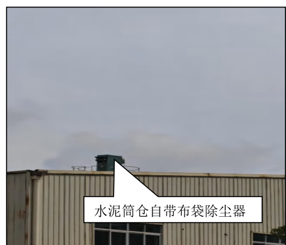
图 4-1-12 水泥筒仓自带布袋除尘器
