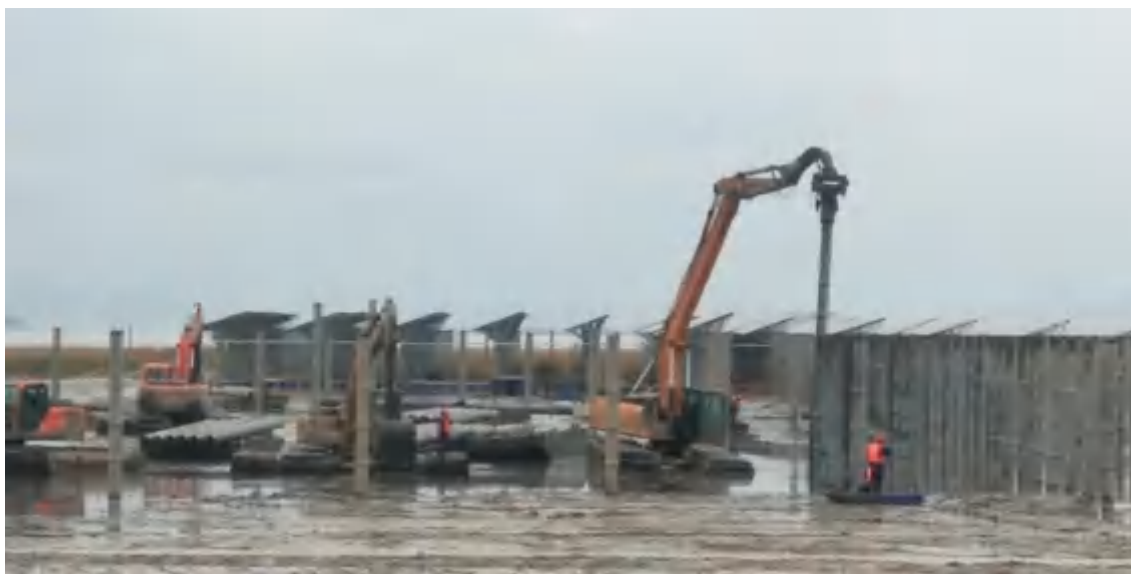
图 2.7-1 水陆两栖打桩机施工示意图
