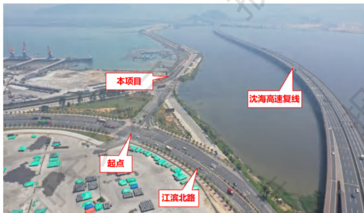
图 2.2-2 项目起点航拍图
