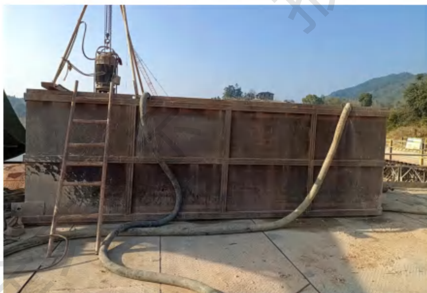
图2.10-8 钢制泥浆池照片
