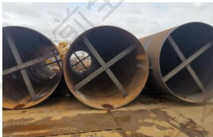
图2.10-7 水中钢护筒十字支撑箍设置示意图
