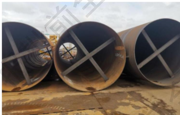
图2.9-5水中钢护筒十字支撑箍设置示意图
