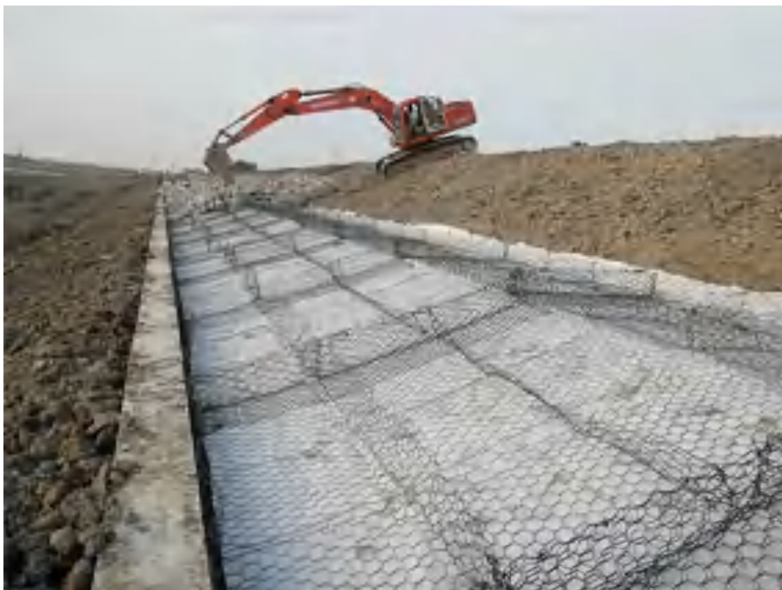
图 2.7-8 块石护面理坡示意图
