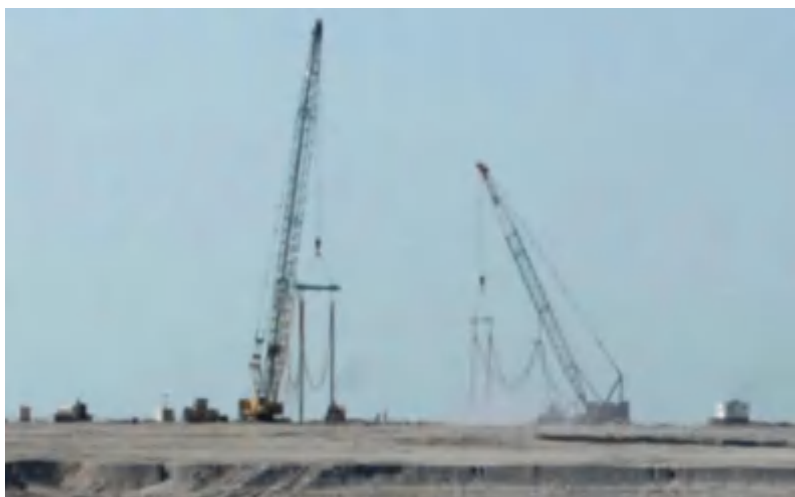
图 2.7-12 地基处理施工照片
