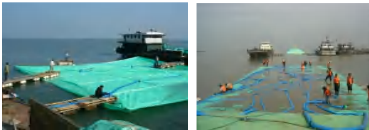
图 2.7-7 充灌砂被施工照片
