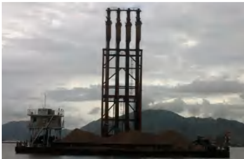
图 2.7-5 砂桩施工照片
