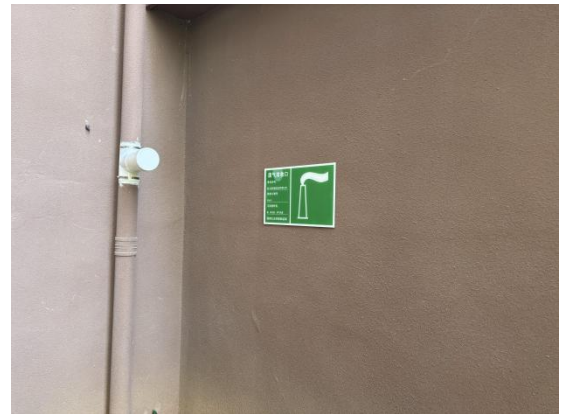
废气采样口及排放标识牌
