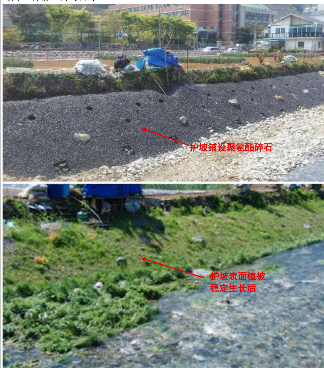
图2-8 聚氨酯碎石护坡案例
