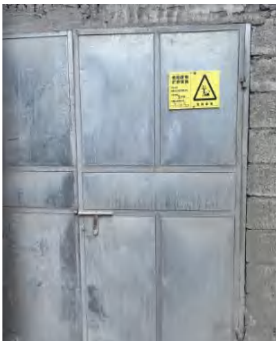
图 3-9 危险废物暂存间
