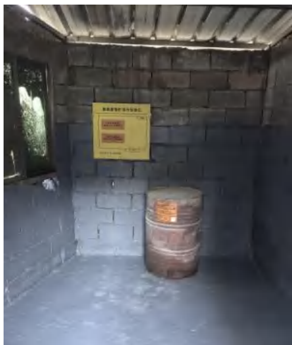
图3-10 一般固废暂存间
