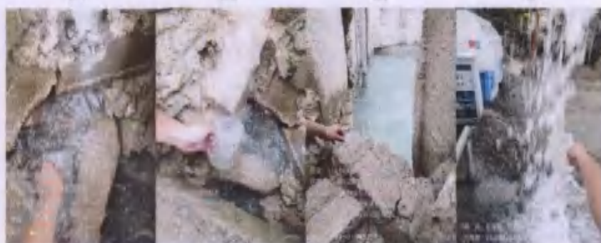
生活污水进口
