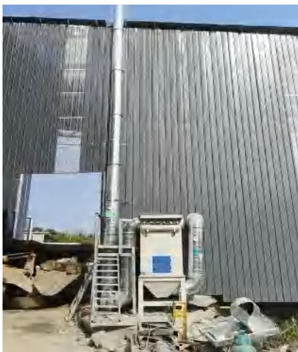
图 3-7 废气处理设施图
