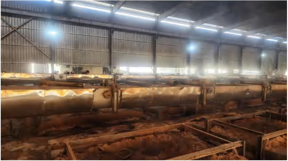
炭化窑废气收集管道
