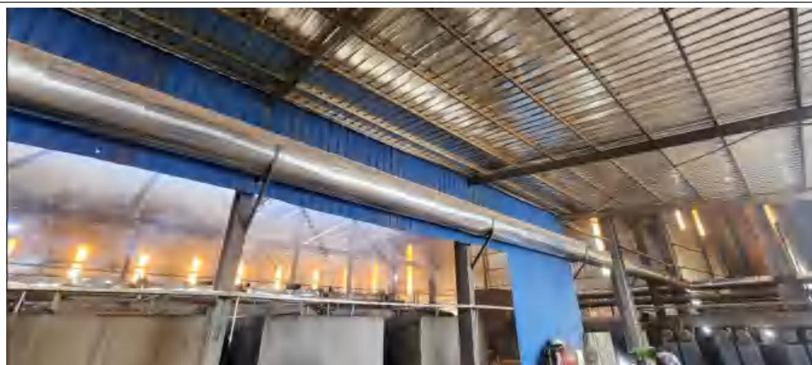
炭化窑废气收集管道
