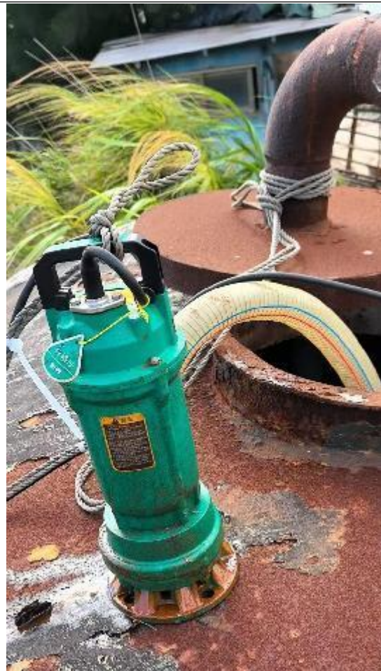
回用水罐配套的回用泵
