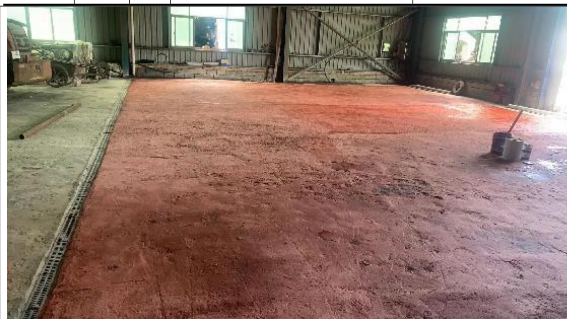
拆解车间防渗、导流沟
