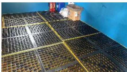
危废间防渗处理
