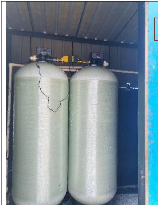
活性炭过滤器
